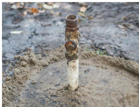
Obrázek 3.: Polymerní injektážní trubka v horní části opatřena závitem
