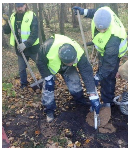
Obrázek 4.: Provádění stabilizace injekční trubky pískem
