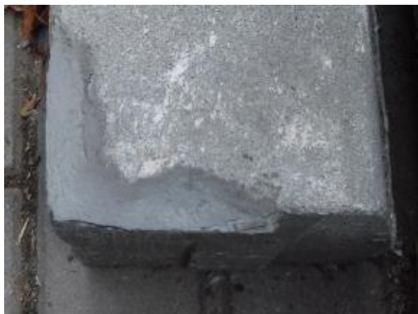
Obrázek 6.: Reprofilovaný obrubník po 4 měsících od aplikace hmoty EP60
