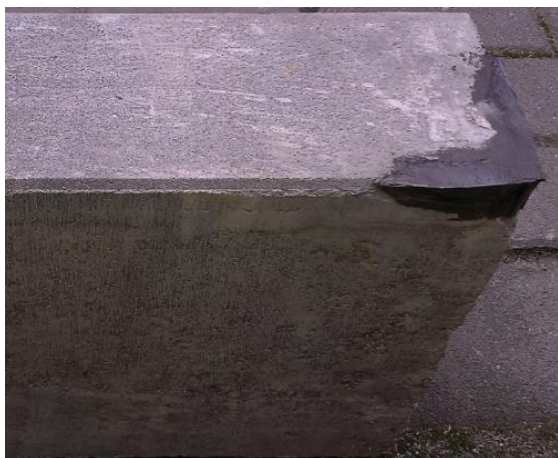
Obrázek 5.: Reprofilovaný obrubník (aplikace hmoty EP60)
