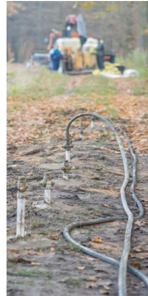
Obrázek 7.: Převedení směsi pomocí gumových hadic
