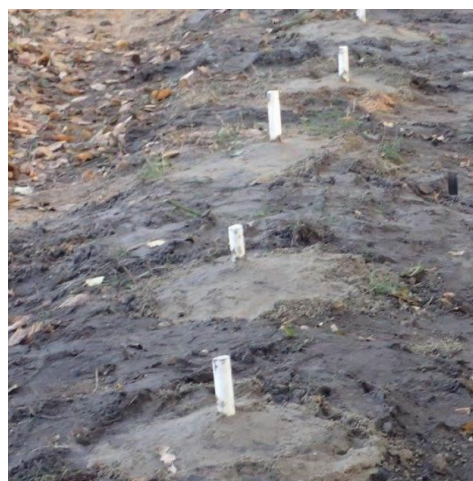
Obrázek 5.: Zabezpečení horní části vrtu betonovým potěrem
