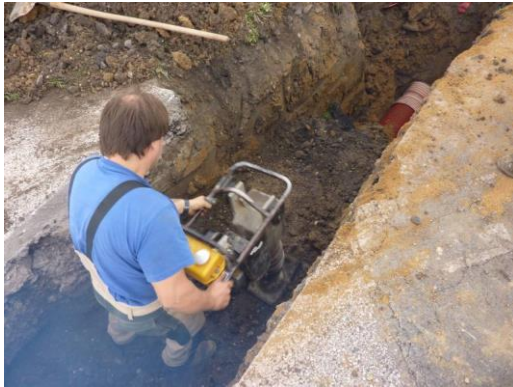
Obrázek 1.: Mechanické zhutnění zeminy [4]
