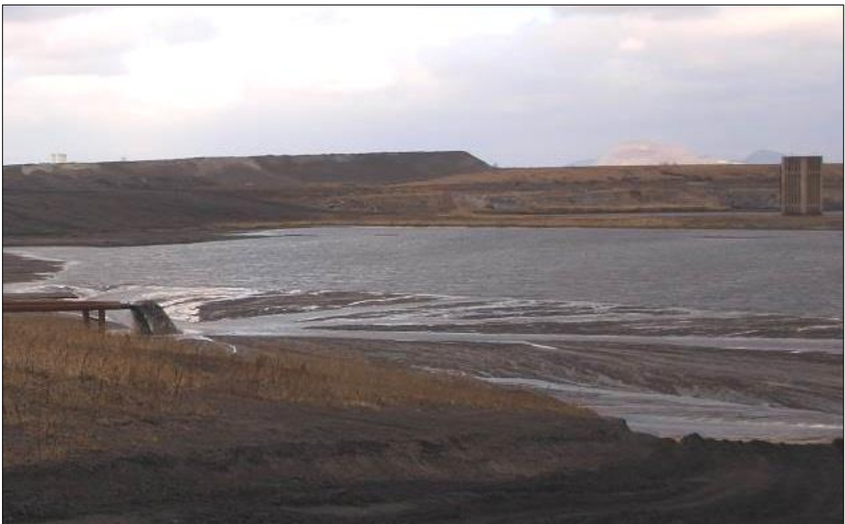
Obrázek 1.: Plavení strusky do zbytkového jezera (v pozadí přepadová věž)
