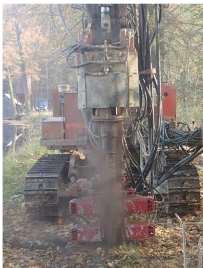
Obrázek 2.: Vyhloubení vrtu – metoda rotačního vrtání při současném pažení
